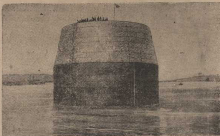
Cajón flotante a manera de cámara hueca, dentro del cual han de trabajar los obreros destinados a echar los cementos de un puente. Cuando este cajón llega al fondo del agua puede trabajarse en él seguramente.
